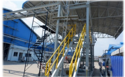
อาคารโหลดใหม่
