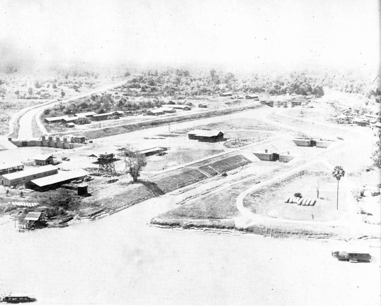
ประตูระบายและประตูเรือสัญจรบรรทัด ปากแม่น้ำน้อย ส่วนหนึ่งของโครงการเจ้าพระยาใหญ่
