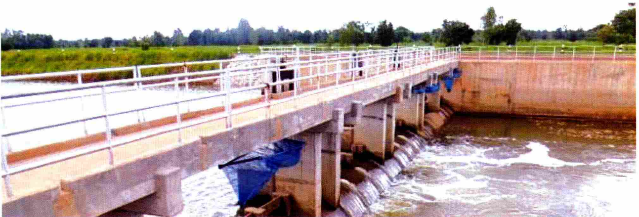
ฝายห้วยซางก่อสร้างแล้วเสร็จ
