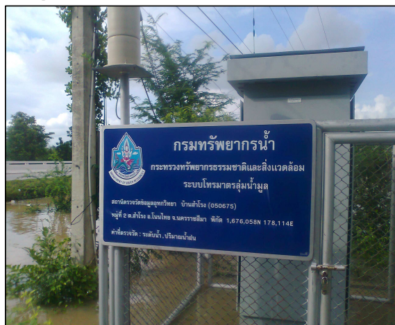
18 ต.ค.53 เข้าปิดระบบไฟฟ้าสถานีบ้านสำโรง
