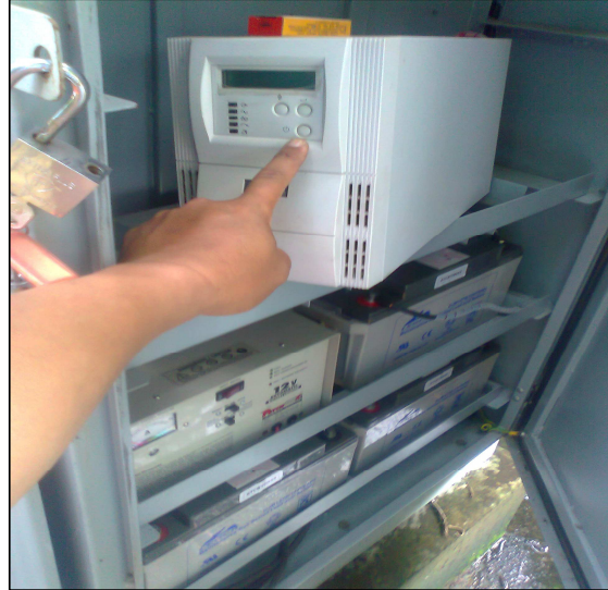
ปิดสวิตช์ OFF เครื่อง UPS และยกขึ้นไว้ที่สูง
