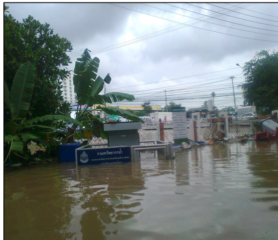
17 ต.ค.53 ไม่สามารถเข้าไปปิดระบบไฟฟ้าได้ทัน
