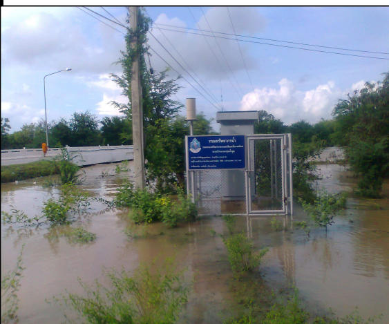
18 ต.ค.53 น้ำเริ่มท่วมสถานีบ้านสำโรง
