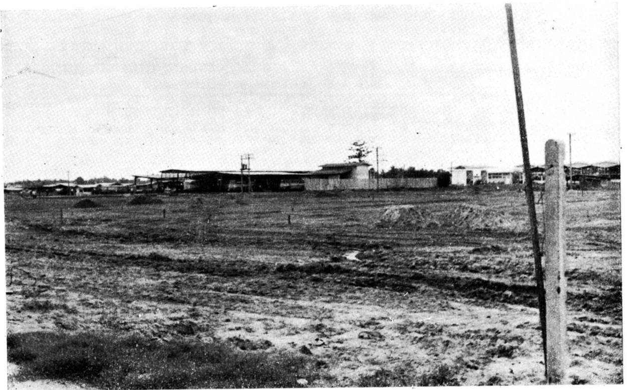
ลานจอดรถ บริษัทขนส่ง จำกัด ขณะเริ่มลงมือก่อสร้างในบริเวณสถานีขนส่งสายเหนือ
