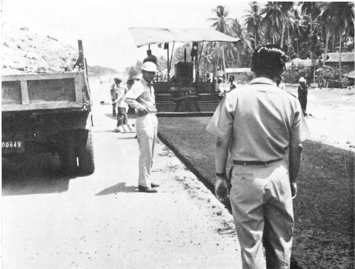
การลาดยางแบบ Asplaltic Concrete ทางสายปัดตานี-นราธิวาส
