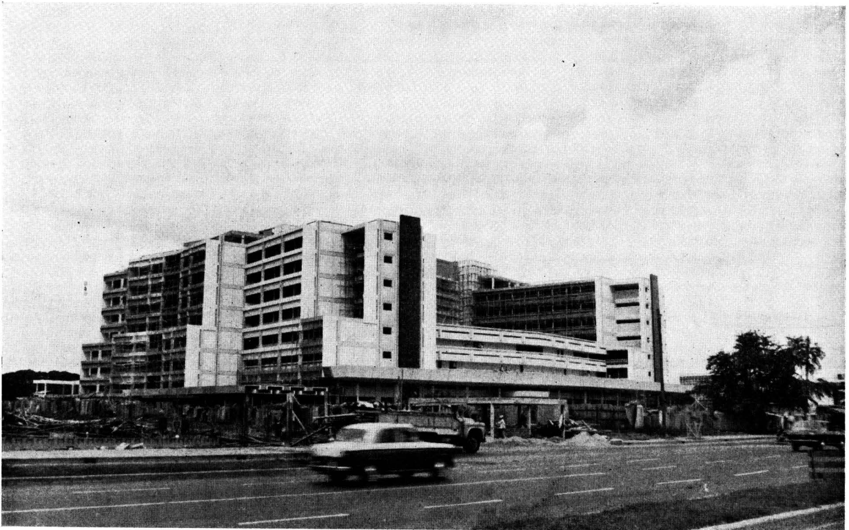
โรงพยาบาลรามาธิบดี ถนนพระราม ๖ อยู่ในระหว่างการก่อสร้าง งานเสร็จประมาณ ๘๐%
