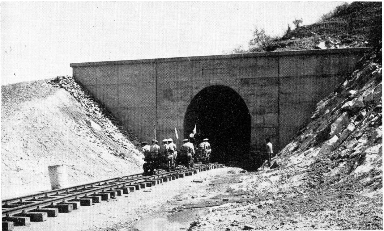
รางที่วางแล้วยังไม่ได้โรยหินที่ปากถ้ำเขาพังเหย โครงการก่อสร้างทางสายแก่งคอย-บัวใหญ่
