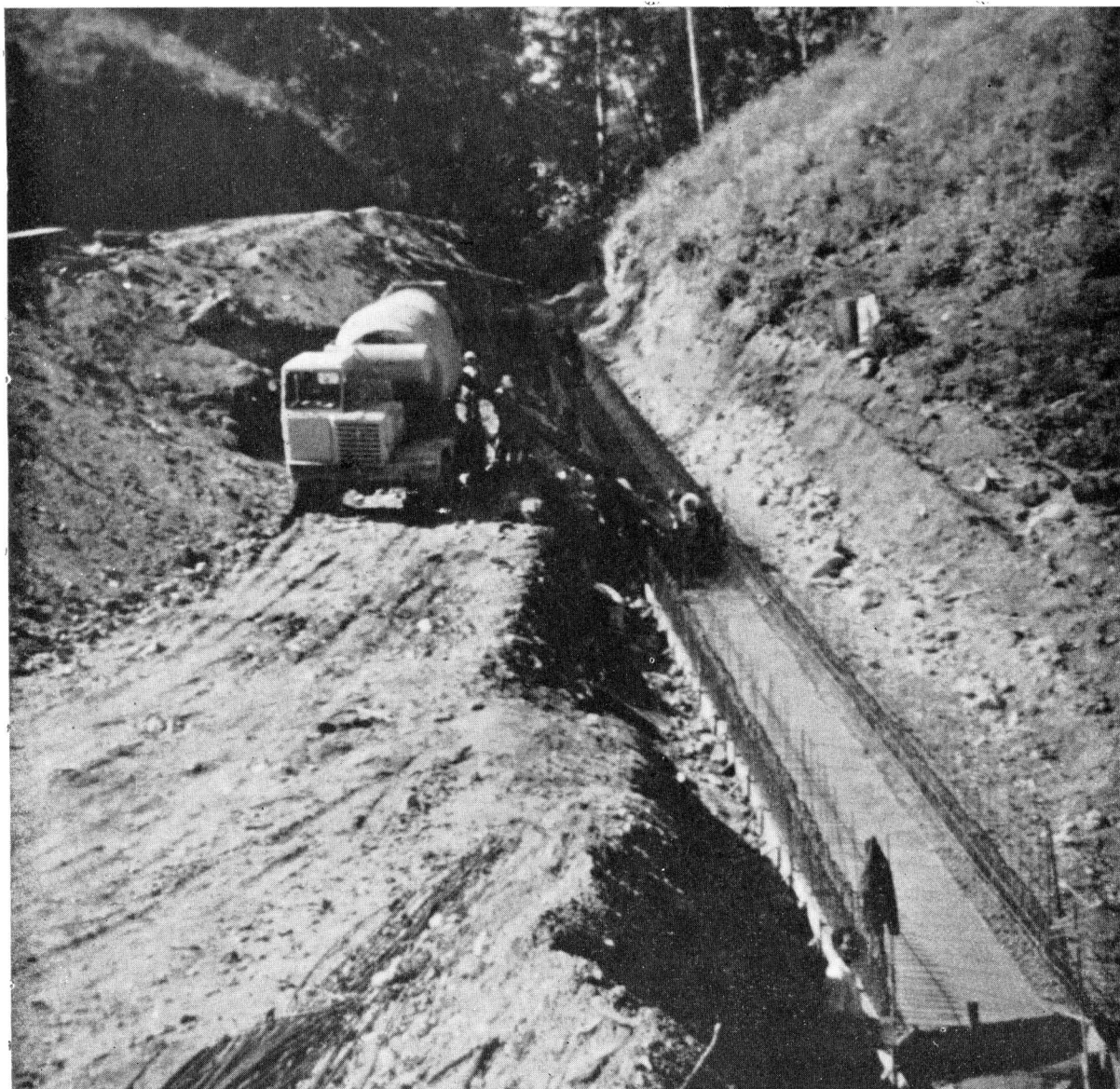
การทำทางระบายน้ำคอนกรีต ทางสายลำปาง-เชียงใหม่
