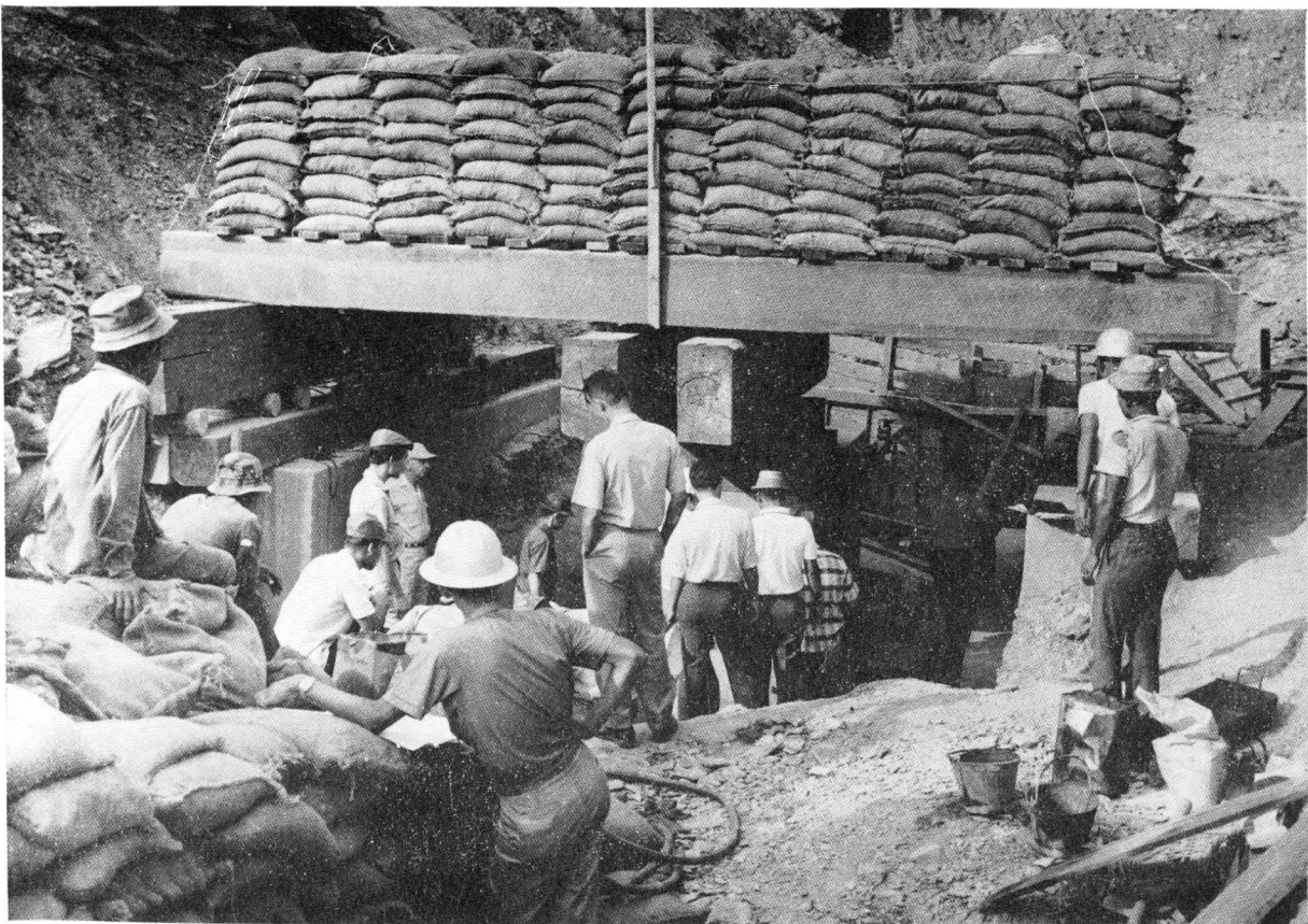
การทดลองรับน้ำหนักบรรทุกของหินฐานรากเขื่อนผาช่อม
