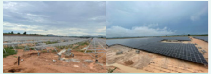
งานติดตั้ง PV Module
