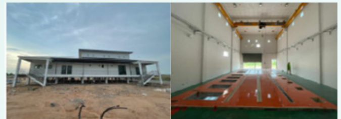
งานก่อสร้างอาคาร Control
