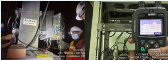
ภาพงานปรับปรุงระบบโทรคมนาคม
