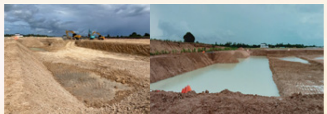
ภาพงานเปิดหน้าดินและขุดดินเพื่อก่อสร้างถังน้ำใส ประมาณ 20,000 ลบ.ม.
