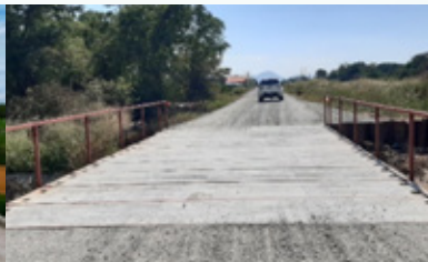
งานก่อสร้างสะพานชั่วคราว
