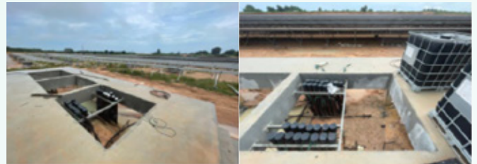
งานติดตั้งตู้ร้อนสายไฟฟ้า
