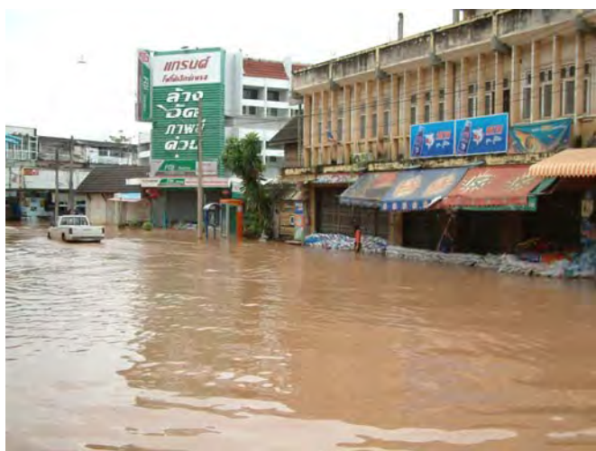
สาธารณูปโภคได้รับความเสียหาย
