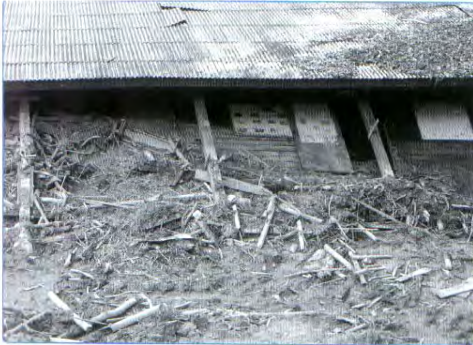
โคลนถล่มอาคารเรียน อ.วังหิน จ.เพชรบูรณ์
