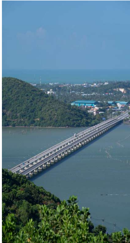
สะพานติณสูลานนท์
