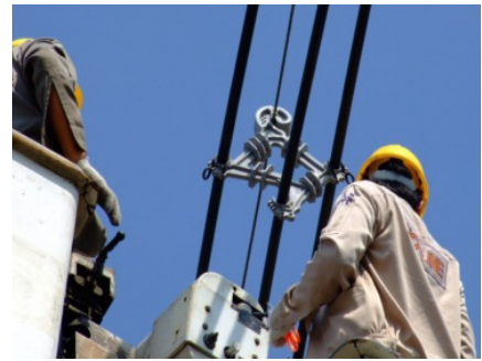
เคเบิลสเปเซอร์ (Cable Spacer)
