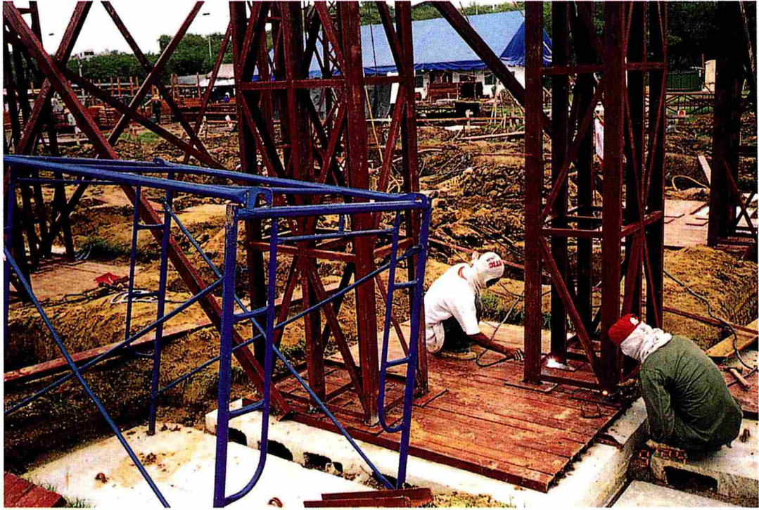
งานติดตั้งเสาเหล็กพระเมรุมาศ
