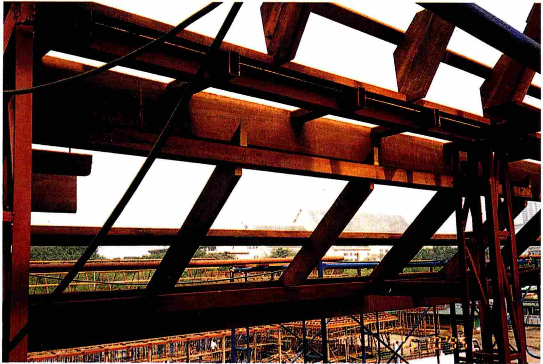
โครงหลังคาปีกนกพระเมรุมาศ
