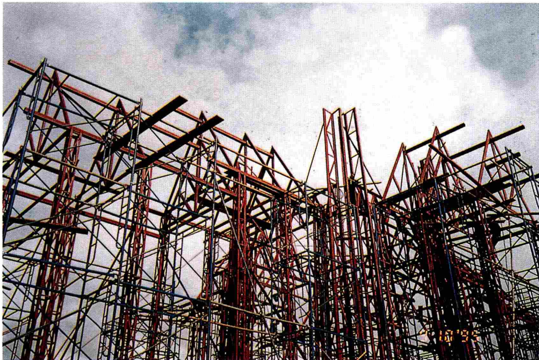
เหล็กประกอบโครงหลังคามุขและเสาศา พระเมรุมาศ
