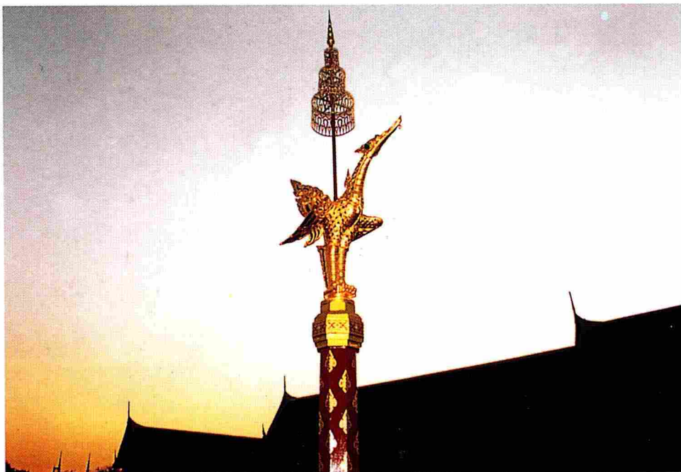
ทวยรูปหงส์ ที่เสาคู่ซ้ายรับมุขด้านตะวันตกของพระเมรุมาศและพระที่นั่งทรงธรรม สำหรับทอดพระภูษา- โยงจากเสาทรงธรรมและพระที่นั่งทรงธรรม ตัวหงส์เป็นลายซ้อนไม้ ปิดกระดาษทองย่น
