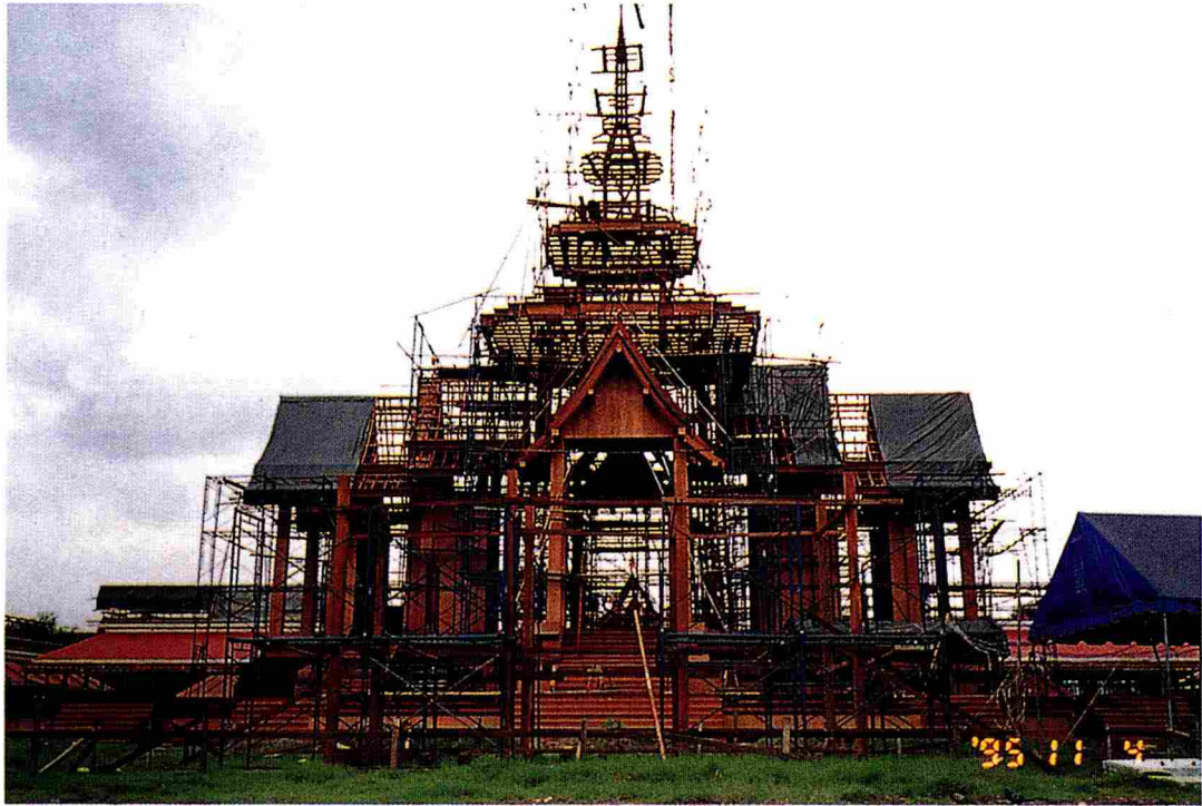
โครงเหล็กยอดมณฑป พระเมรุมาศ
