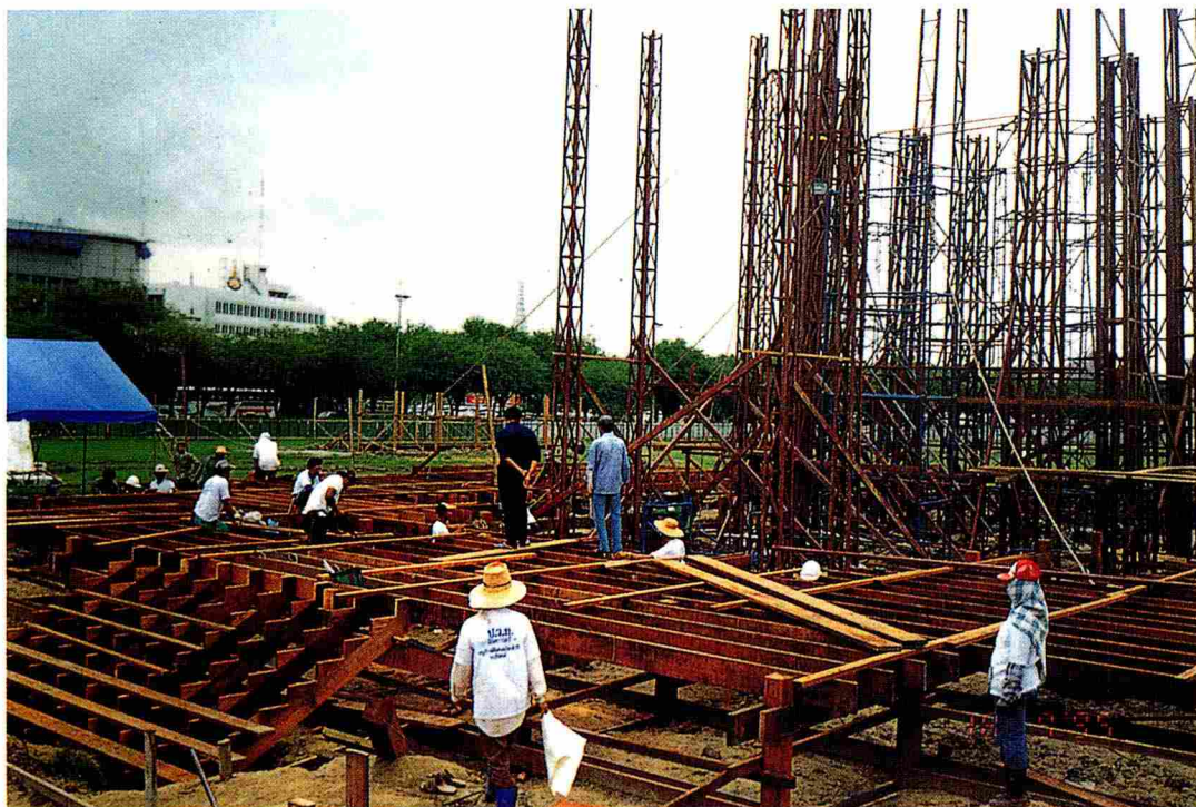
งานวางคานตงไม้ลานโดยรอบพระเมรุมาศ
