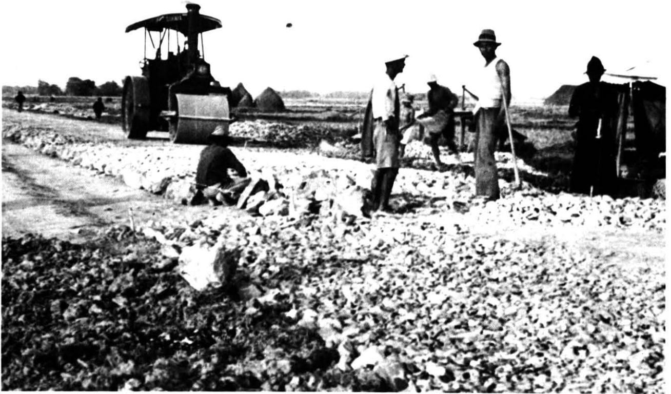
การตัดถนนสายกรุงเทพฯ - ดอนเมือง Construction of the road from Bangkok to Don Muang.
