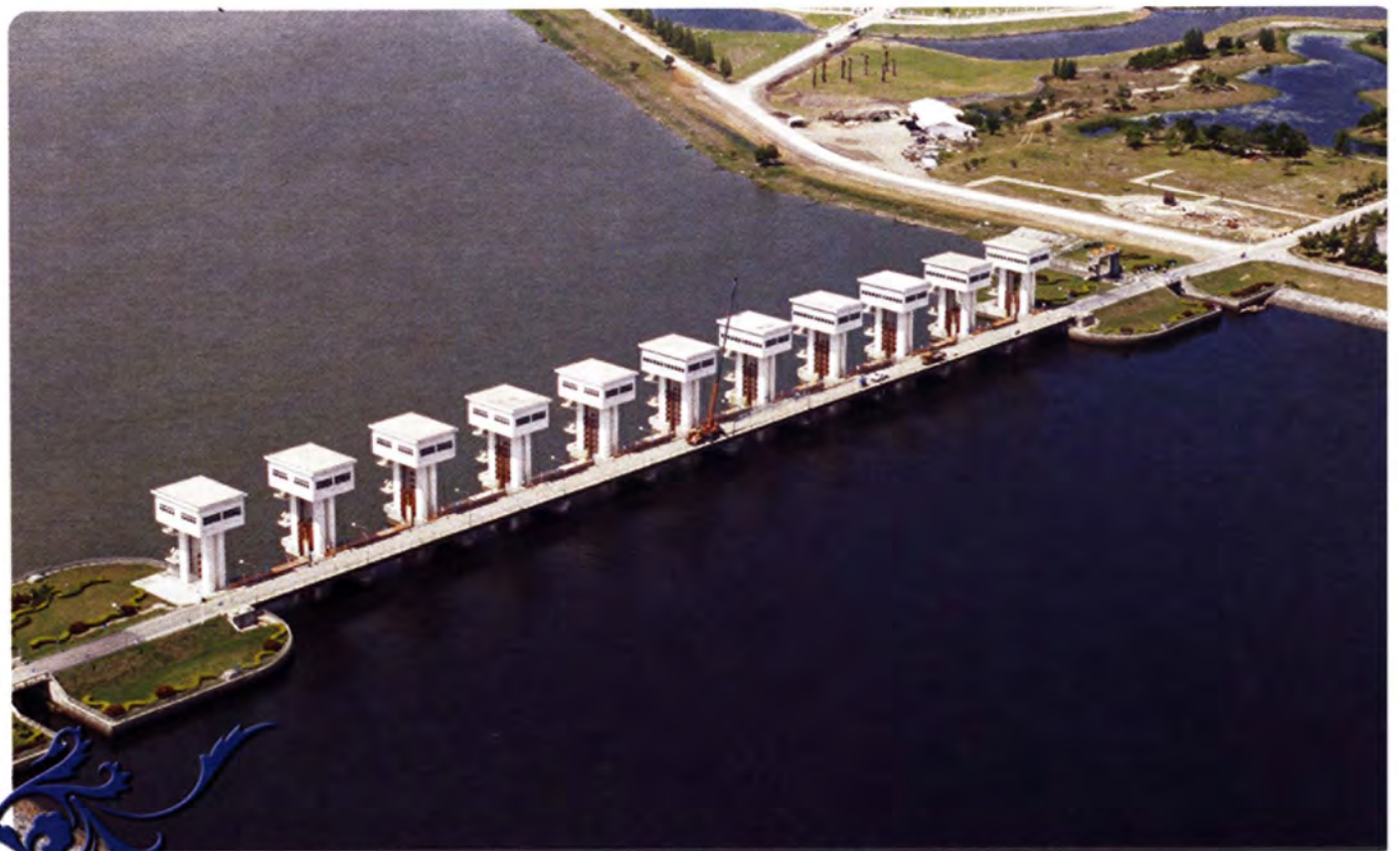
ประตูระบายน้ำอุทกวิภาชประสิทธิ์ อ.ปากพนัง จ.นครศรีธรรมราช
