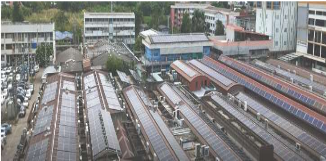
ภาพที่ 5 โซลาร์รูฟท็อป (Solar Rooftop) ที่อาคารโรงพยาบาลลำปาง
