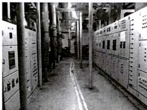
ภายในห้อง Chiller
