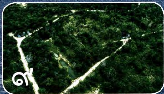
คันกันน้ำ.....๑๐๐ บรรเทาน้ำหลาก อย่างเหมาะสม
