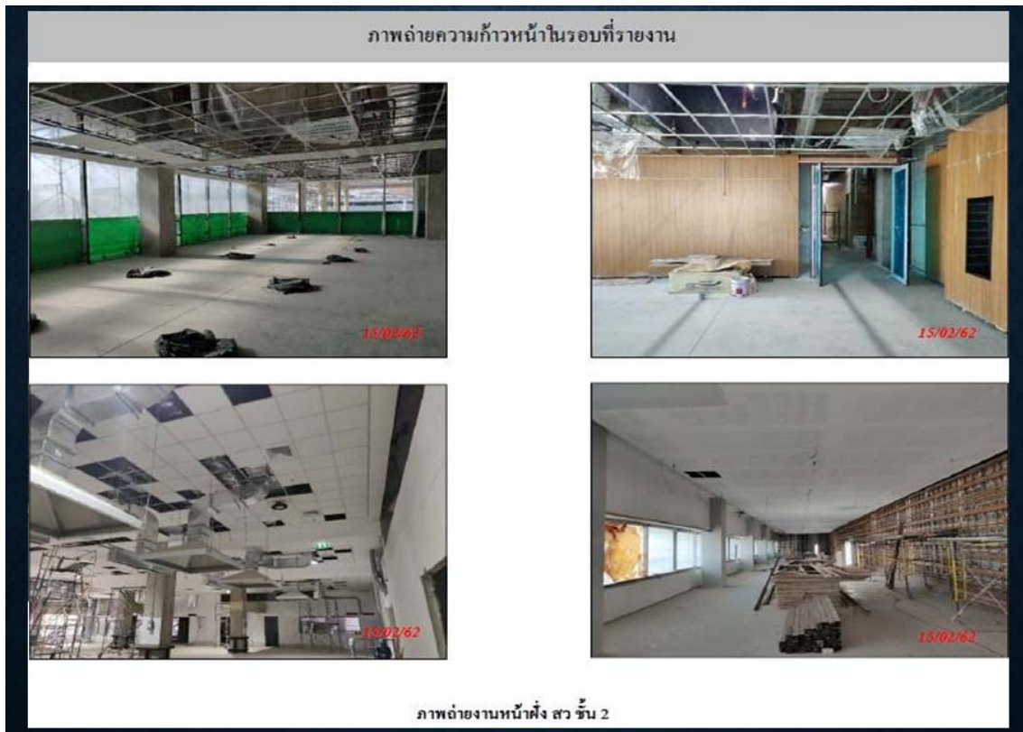
ภาพที่ ๔-๑๑ ความก้าวหน้าพื้นที่ก่อสร้างโรงพิมพ์
