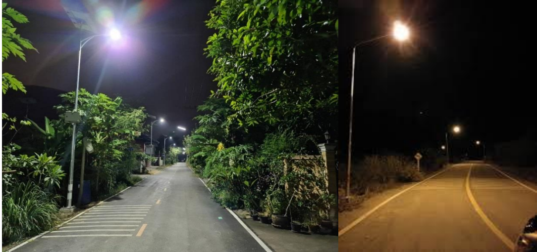
ภาพที่ ๓๓ ไฟฟ้าสาธารณะ เปิดตั้งแต่เวลา ๑๘.๐๐ - ๐๖.๐๐ นาฬิกา ตลอด ๓๖๕ วัน
