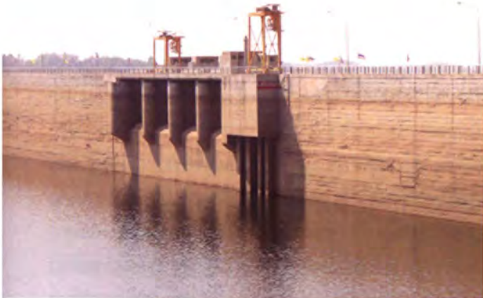
คลองชลประทาน (Irrigation Outlet) และเขื่อนดินปิดช่องเขาต่ำ (Saddle Dam) เป็นเขื่อนดินสูง ๔๖ เมตร กว้าง ๘ เมตร ยาว ๓๕๐ เมตร
