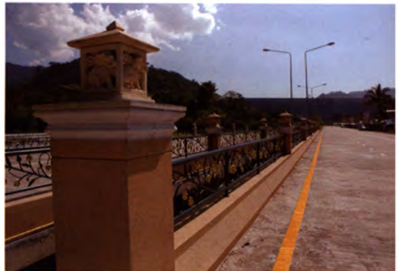
คลองชลประทาน (Irrigation Outlet) และเขื่อนดินปิดช่องเขาต่ำ (Saddle Dam) เป็นเขื่อนดินสูง ๔๖ เมตร กว้าง ๘ เมตร ยาว ๓๕๐ เมตร
