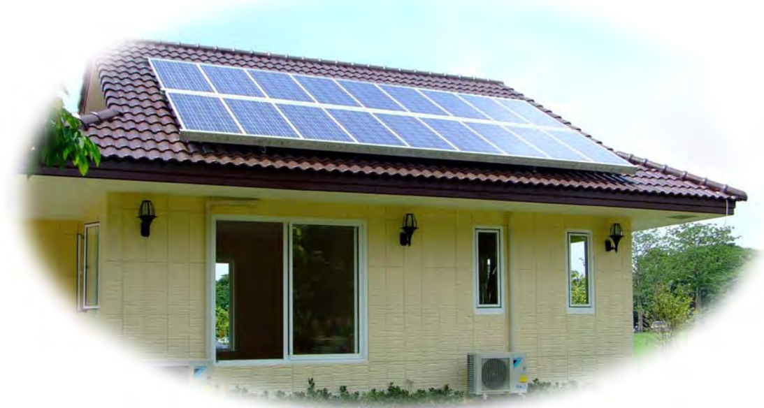
รูปที่ 2-7 ตัวอย่างการติดตั้งระบบผลิตไฟฟ้าด้วยพลังงานแสงอาทิตย์เชื่อมต่อสายส่ง ณ วังสวนจิตรลดา ดำเนินการโดยกรมการพลังงานทหาร ศูนย์อุตสาหกรรม ป้องกันประเทศและพลังงานทหาร สำนักปลัดกระทรวงกลาโหม
