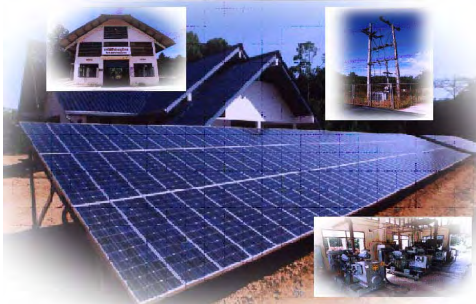
รูปที่ 2-9 ระบบผลิตไฟฟ้าด้วยพลังงานแสงอาทิตย์แบบผสมผสานกับเครื่องยนต์ดีเซลสำหรับหมู่บ้านชนบท ขนาด 85 kWp บ้านบาตูปูเต๊ะ ตำบลเกาะลิบง อำเภอกันตัง จังหวัดตรัง
