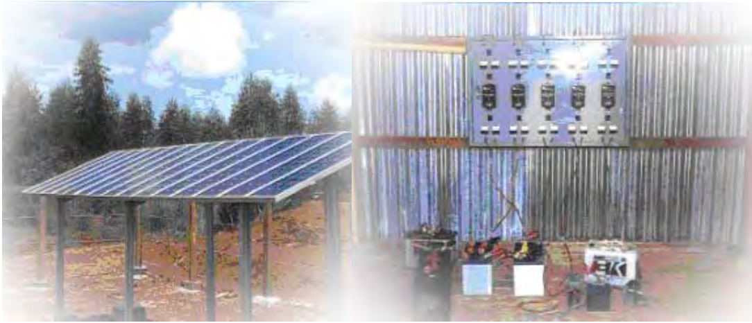
รูปที่ 2-4 ระบบประจุแบตเตอรี่ด้วยพลังงานแสงอาทิตย์แบบรวมศูนย์ ขนาดระบบ ละ 800 วัตต์ดำเนินการโดยกรมโยธาธิการ (เดิม) กระทรวงมหาดไทย ติดตั้ง ปี พ.ศ. 2531-2540
