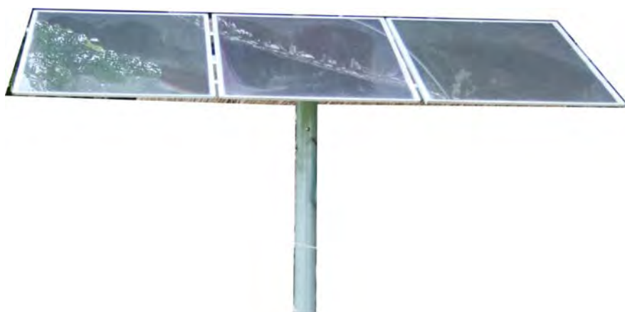
ข. แผงเซลล์แสงอาทิตย์แบบฟิล์มบาง (Amorphous Silicon หรือ Thin Film)
