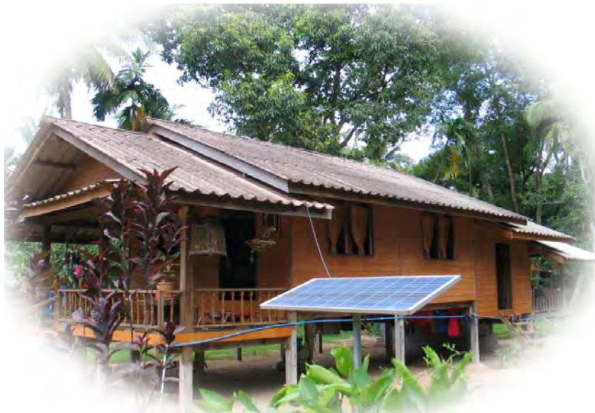
รูปที่ 2-11 ระบบผลิตไฟฟ้าสำหรับครัวเรือน (SHS) (ดำเนินโครงการโดยการไฟฟ้าส่วนภูมิภาค)
