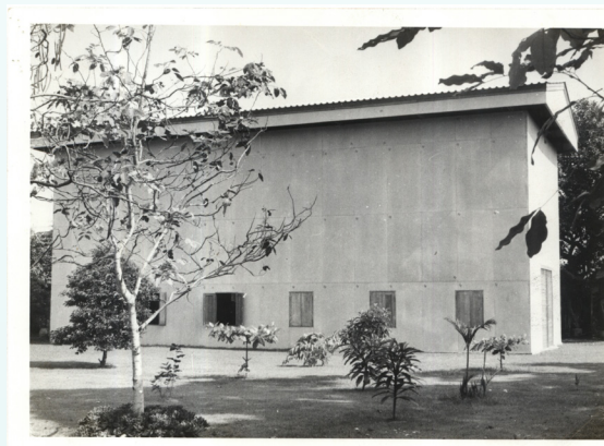
ภาพ : โรงงานปั้นหล่อชั่วคราวในบริเวณรัฐสภา ถ.อุทองใน
