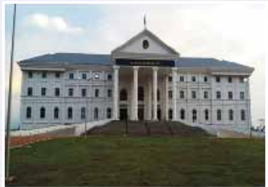
อาคารที่ทำการศาลปกครองขอนแก่น
