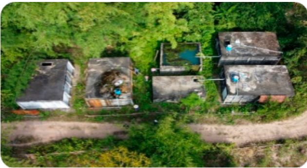
ระบบประปาหมู่บ้านสันดอนแก้ว ก่อนปรับปรุง
