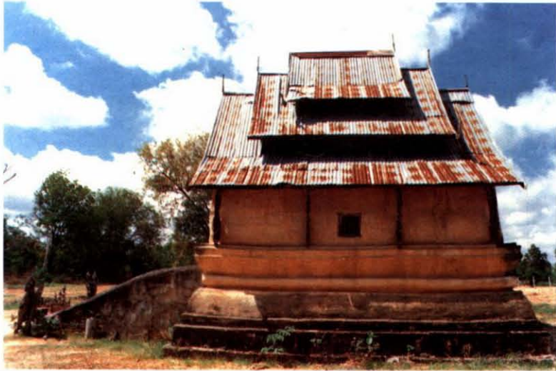
ข. 1.2 สร้างด้วยอิฐถือปูน แบบ ข. 1.2.1 : ไม่มีเสารับปีกนก (ไม่มีมุขหน้า) สิมวัดศรีฐาน บ.หนาด อ.ธวัชบุรี จ.ร้อยเอ็ด
