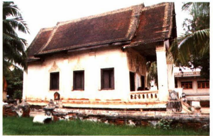
แบบ ข. 1.2.1 : ไม่มีเสารับปีกนก (มีมุขหน้า) สิมวัดใหม่อัมพวัน อ.เมือง จ.นครราชสีมา
