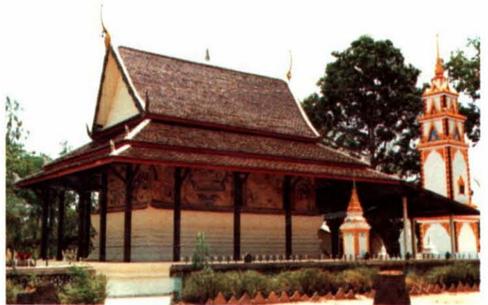
แบบ ข. 1.2.2 : มีเสารับปีกนก สิมวัดโพธาราม บ.ดงบัง อ.นาตุ้ม จ.มหาสารคาม
