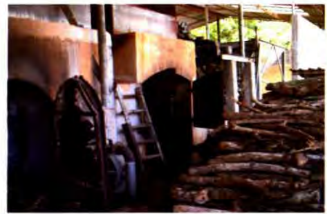
สภาพโรงงาน
