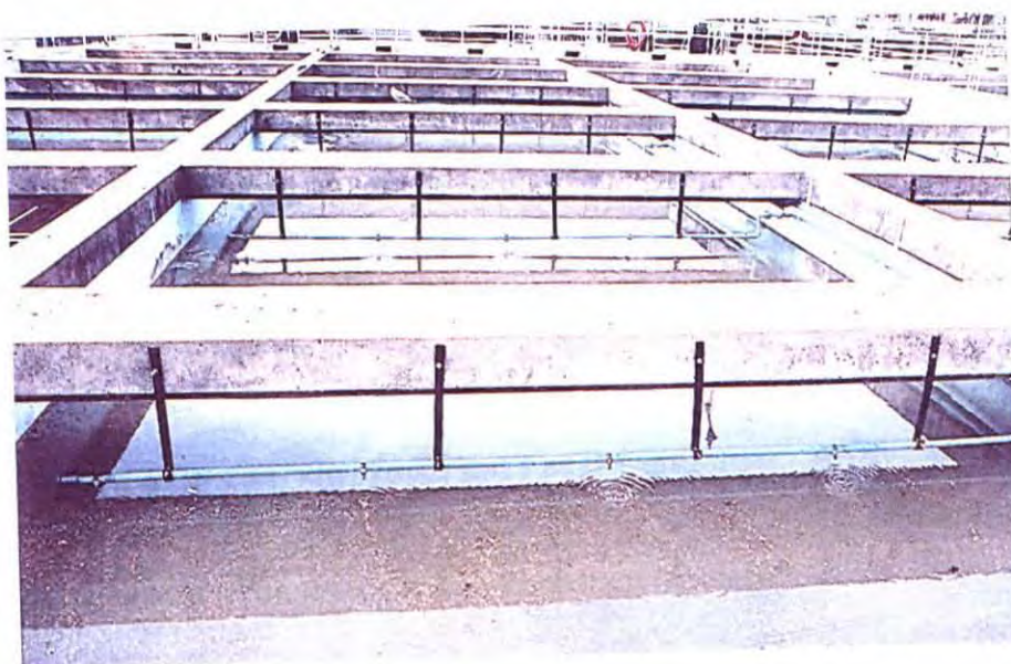
ถังตกตะกอน (Sedimentation Tank)
