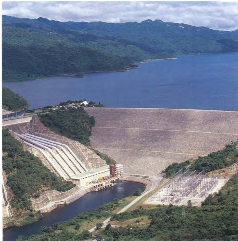
โรงไฟฟ้าระบบสูบลบติดตั้งแห่งแรกที่เขื่อนศรีนครินทร์
