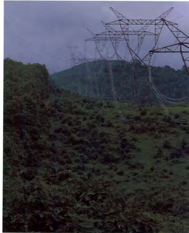
สายส่งขนาดแรงดัน ๕๐๐ กิโลโวลต์ ส่งกระแสไฟฟ้าจากโรงไฟฟ้าแม่เมาะถึงกรุงเทพฯ
