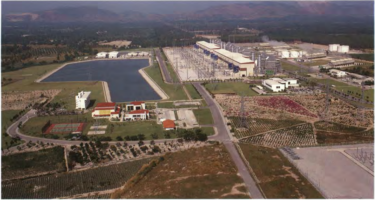
โรงไฟฟ้าพลังความร้อนร่วมระยอง
