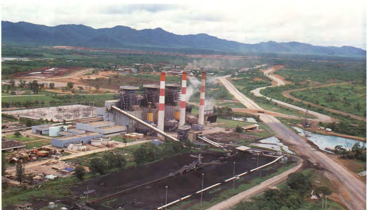
โรงไฟฟ้าแม่เมาะเครื่องที่ ๑,๒,๓
