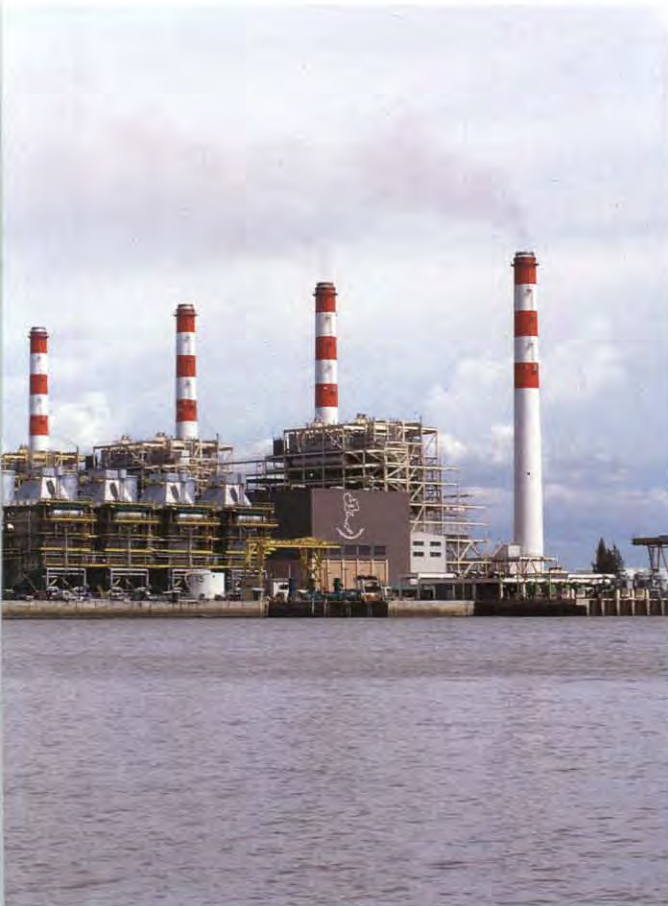
โรงไฟฟ้าพลังความร้อนร่วมแห่งแรก ตั้งอยู่ที่โรงไฟฟ้าบางปะกง
