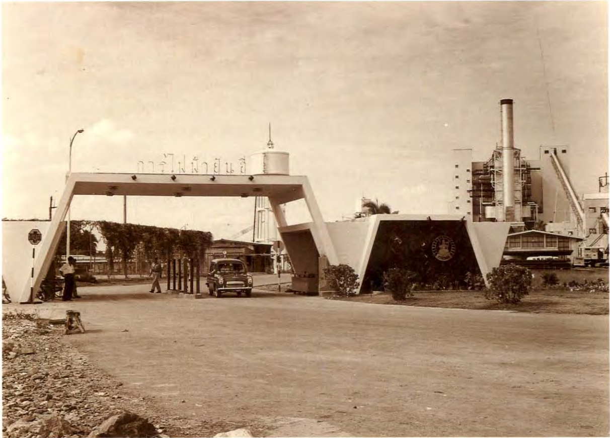
โรงไฟฟ้าพระนครเหนือ เมื่อแรกก่อสร้าง
