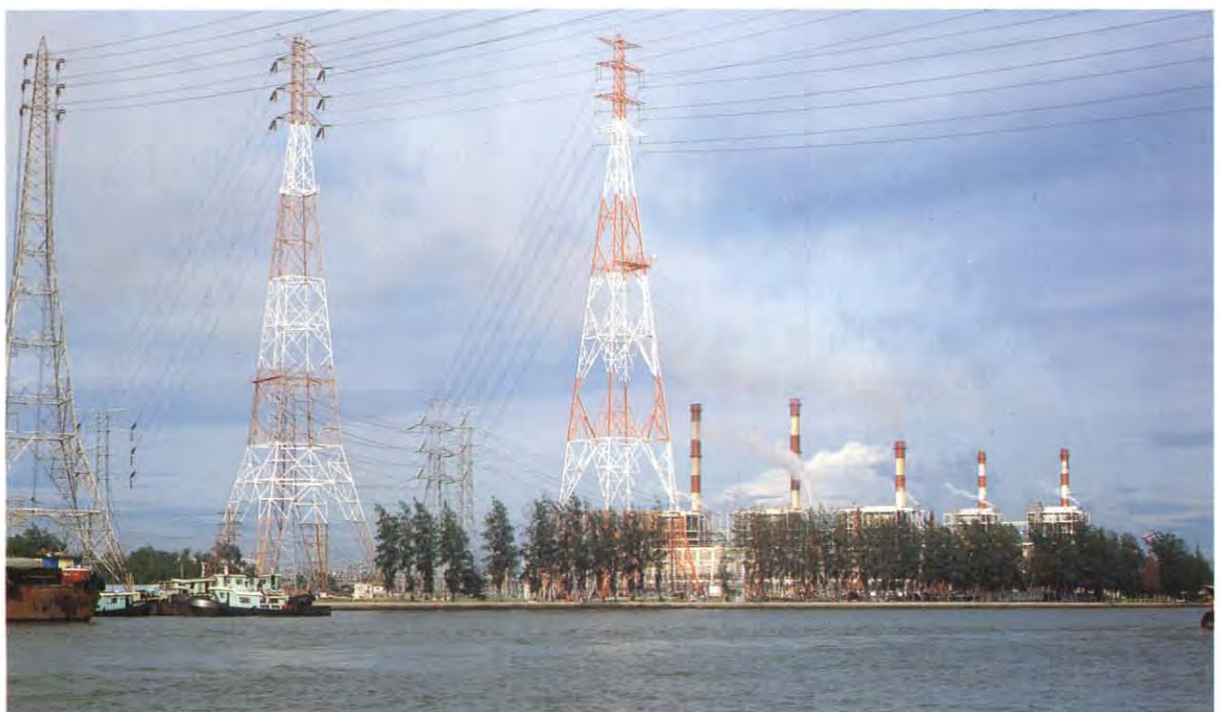
โรงไฟฟ้าพระนครใต้ แล้วเสร็จในปี พ.ศ.๒๕๑๔
