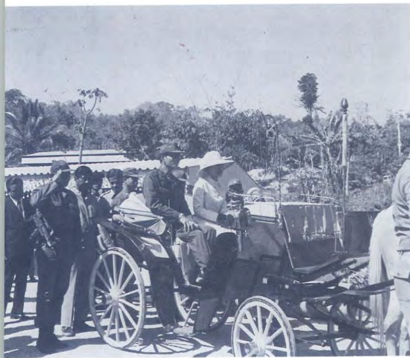
เสด็จฯ เปิดโรงไฟฟ้าบ้านยาง อำเภอลำปาง จังหวัดเชียงใหม่ เมื่อวันที่ ๑ กุมภาพันธ์ พ.ศ.๒๕๑๗
