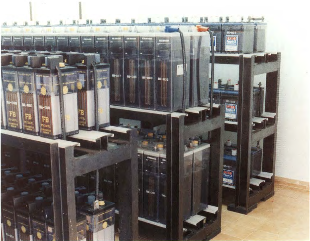
แบตเตอรี่สำรองที่ใช้ในสถานีไฟฟ้าแรงสูง
