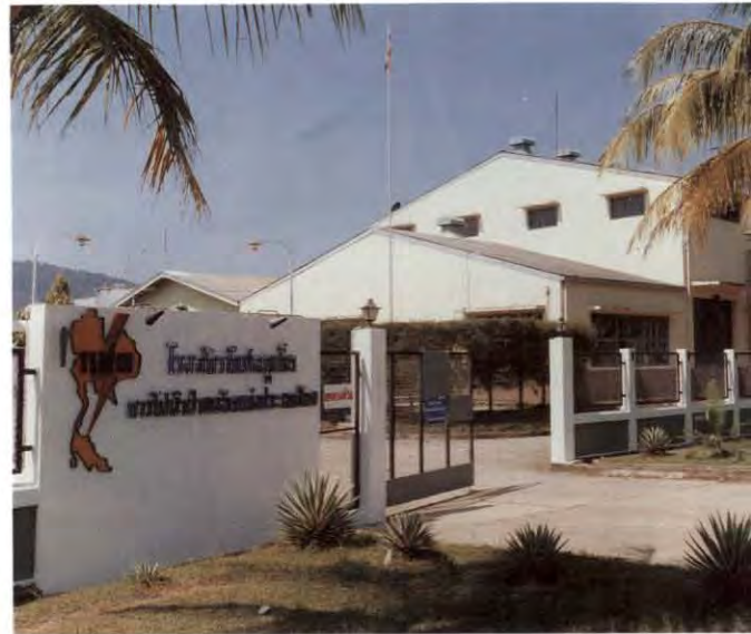
โรงไฟฟ้าดีเซลภูเก็ต ทำหน้าที่จ่ายไฟเสริมในจังหวัด ในระยะที่ระบบส่งยังไม่พัฒนา
