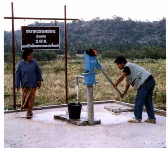
บ่อน้ำบาดาล
