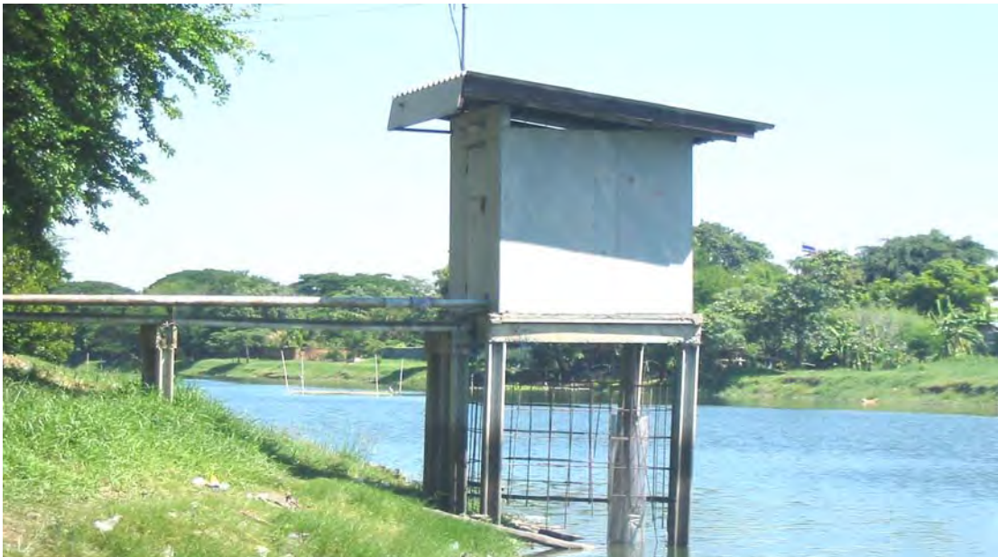
รูปภาพแสดงการติดตั้งโรงสูบน้ำ
