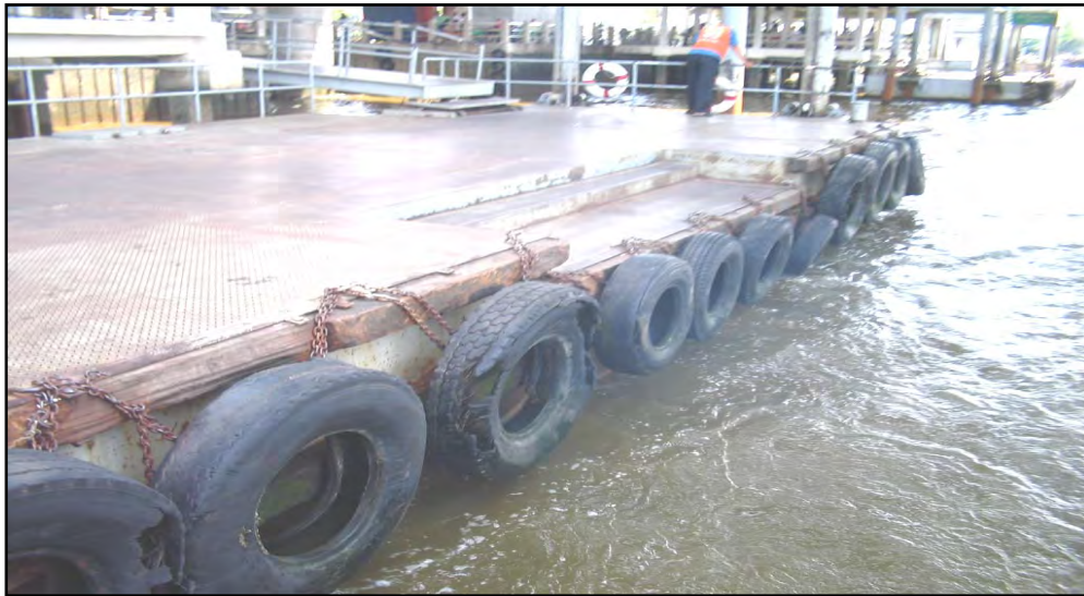
รูปภาพแสดงด้านหน้าโป๊ะเทียบเรือต้องมีอุปกรณ์กันเรือกระทบโป๊ะเทียบเรือ
