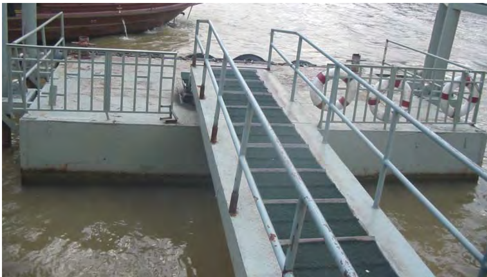
สะพานปรับระดับ
