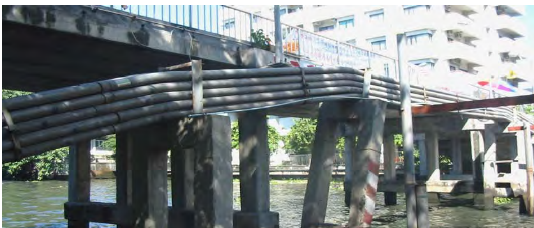
รูปภาพแสดงการวางท่อนานไปกับสะพาน
