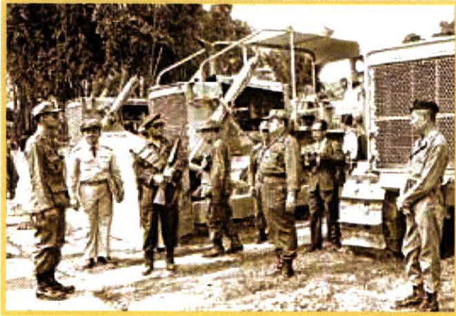
เสด็จฯ ไปถนนห้วยมงคลขณะกำลังก่อสร้าง
