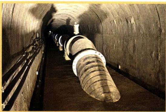
อุโมงค์นำน้ำลอดใต้ภูเขาระยะทางกว่า ๗๐๐ เมตร
