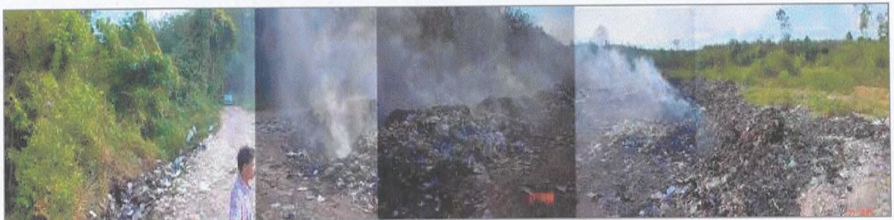
ภาพที่ 3.3-3 สถานที่กำจัดขยะมูลฝอยของเทศบาลตำบลแม่ขรี
