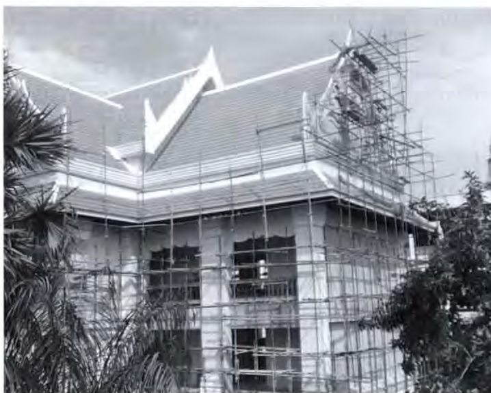
อาคารระหว่างการก่อสร้าง
