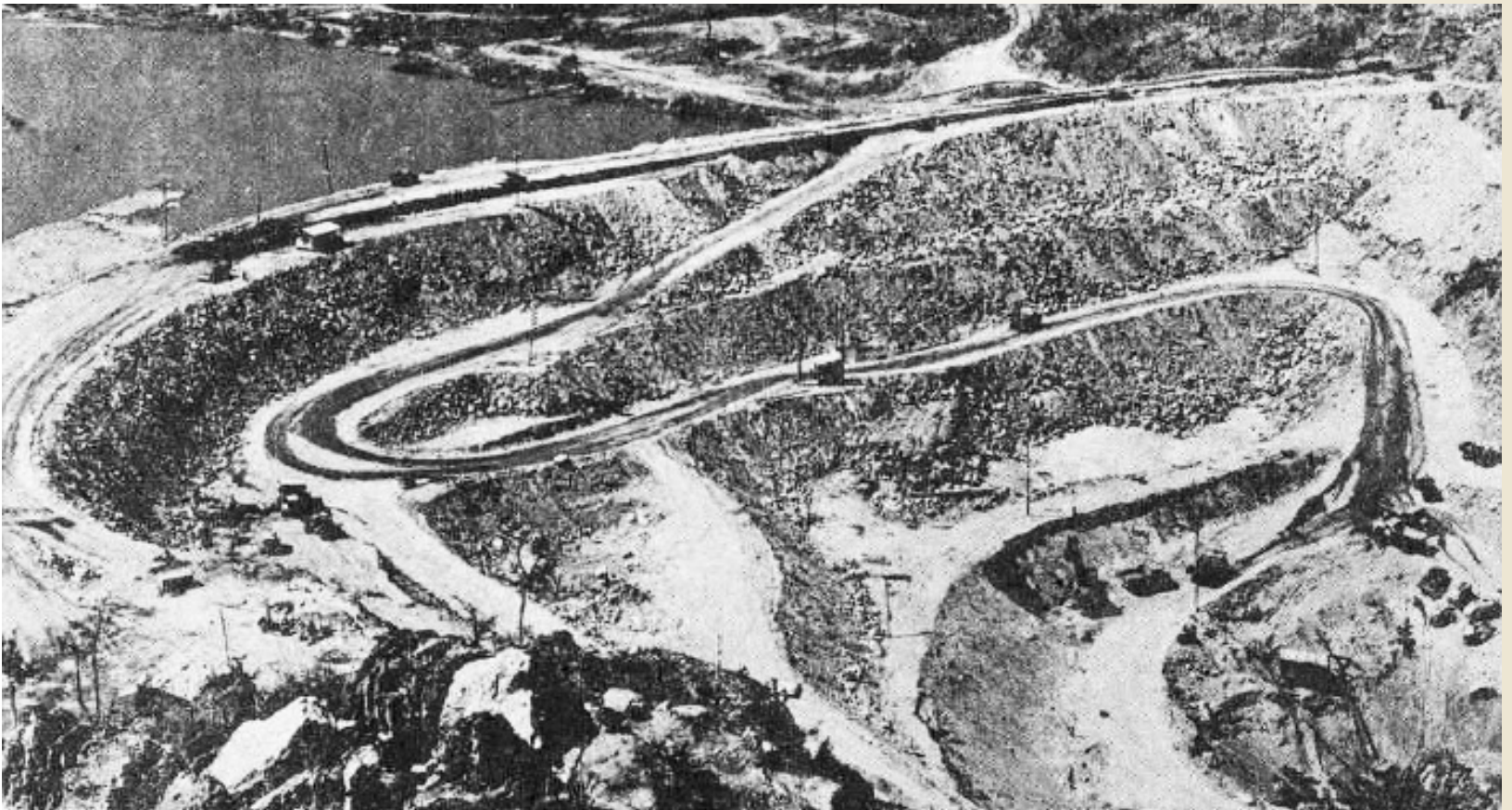
| กำแพงช่องทางด้านเหนือน้ำเมื่อเกือบแล้วเสร็จ
