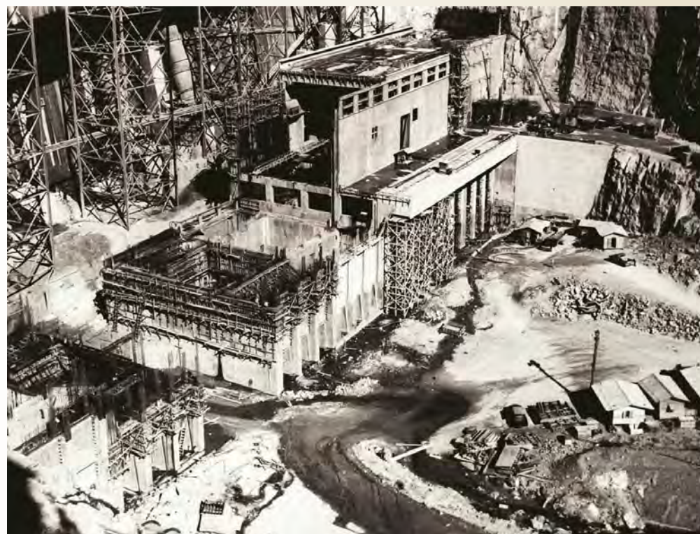
การก่อสร้างอาคารไฟฟ้าและการติดตั้งท่อส่งน้ำเข้าเครื่องกังหันน้ำ
