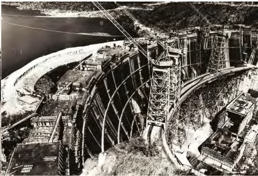
รูปด้านข้างตัวเขื่อน แสดงการเทคอนกรีตได้ครบ ๑,๐๐๐,๐๐๐ ลบ.ทล (๗๖๕,๐๐๐ ลบ.ม.) เมื่อวันที่ ๑๗ กรกฎาคม พ.ศ. ๒๕๐๕
