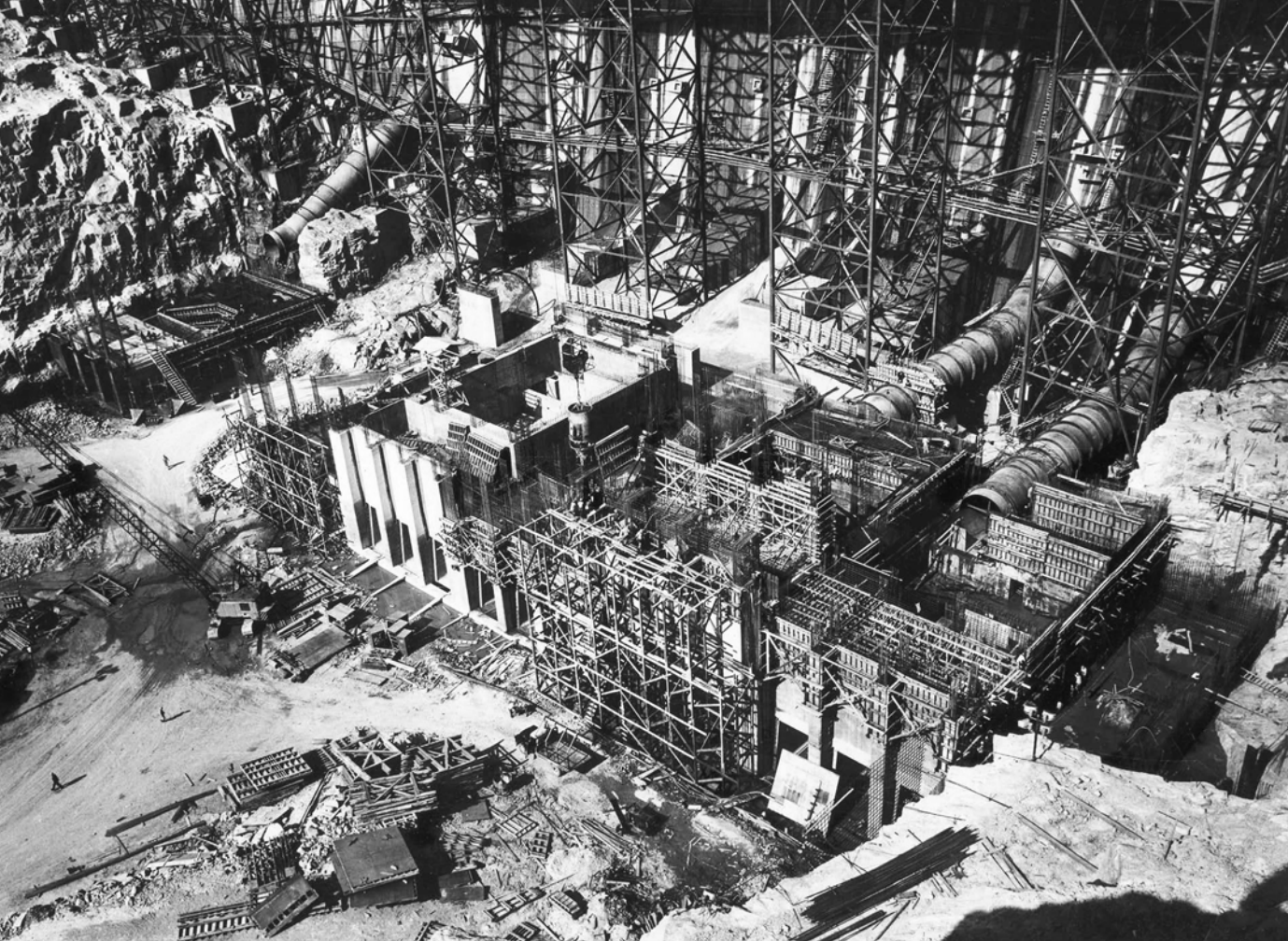
| โรงไฟฟ้าขณะกำลังก่อสร้าง เมื่อวันที่ ๔ มิถุนายน พ.ศ. ๒๕๐๕
