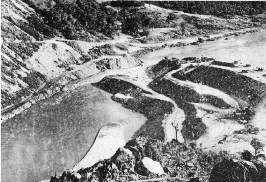
| การเตรียมปิดกั้นบด้นเหนือน้ำ
