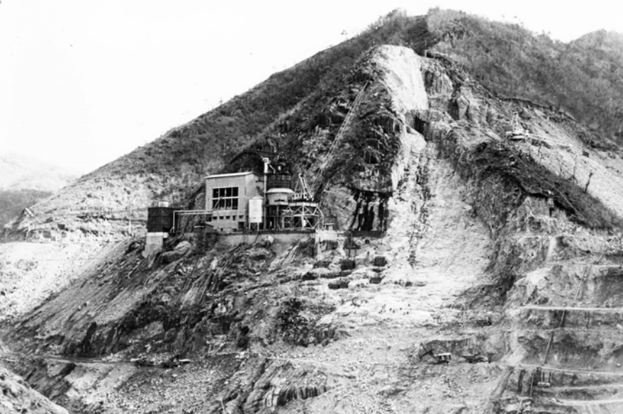
| โรงน้ำแข็ง โรงผสมคอนกรีต และถังเก็บปูนซีเมนต์
