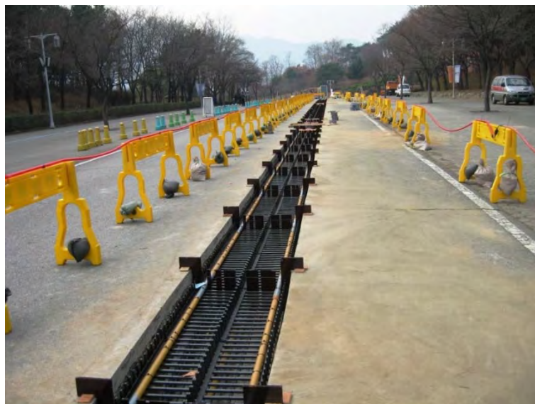
รูปที่ 4-4 ตัวส่งบนพื้นดินของการอัดประจุไฟฟ้าแบบเหนี่ยวนำ
