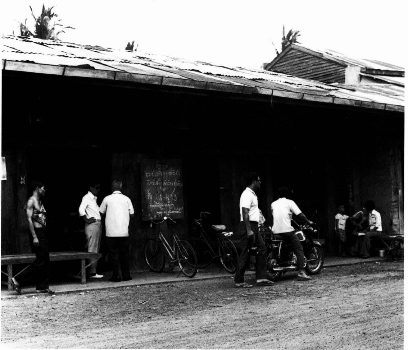
สำรวจอาคารเก่าที่อุบลราชธานีกับอาจารย์มานิต-อาจารย์ศรีศักร
