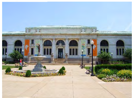
อาคารห้องสมุดประชาชนนครหลวงโคลัมบัส
