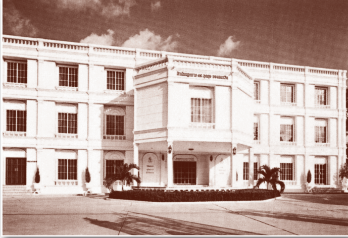
อาคารสำนักงานหลังแรกที่สุขุมวิท ซอย ๕
