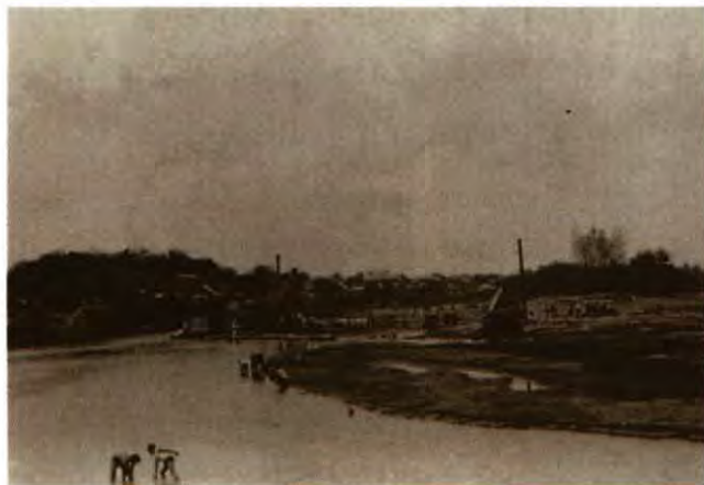
การวางฐานรากสะพานรัชฎาภิเศกนครลำปาง
