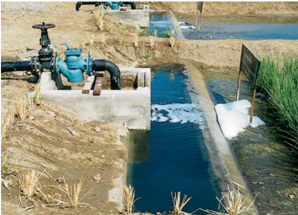
ภาพที่ 8 ลักษณะการให้น้ำหรือการระบายน้ำเสียเข้าแปลงบำบัดน้ำเสียด้วยระบบหมุนำกรองน้ำเสีย
