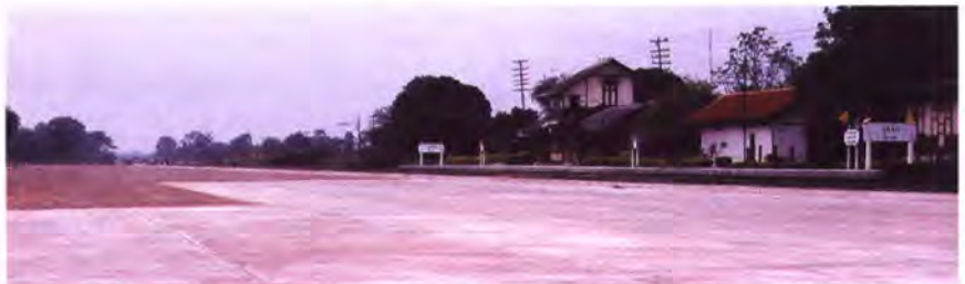
ย่านกองเก็บตู้สินค้าคอนเทนเนอร์ (Container Yard) ในภูมิภาคที่กุดจิก (นครราชสีมา) ซึ่งเสร็จสมบูรณ์เป็นแห่งสุดท้าย (จากจำนวน 4 สถานี)
