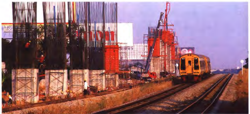
งานก่อสร้างด้านวิศวกรรมโยธาของโครงการระบบขนส่งทางรถไฟเชื่อมท่าอากาศยานสุวรรณภูมิ และสถานีรับส่งผู้โดยสารอากาศยานในเมือง
