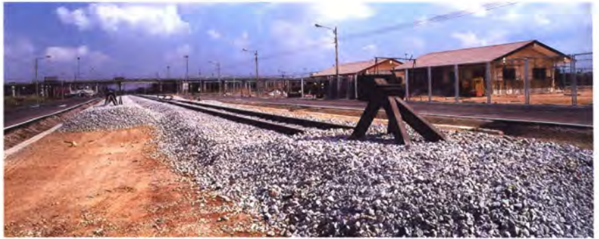
ย่านพักรถสถานีไอซีดี ลาดกระบัง ตามโครงการก่อสร้างเพื่อขยายขีดความสามารถของสถานีไอซีดี ลาดกระบัง
