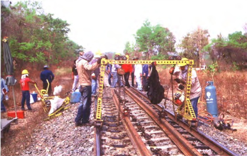
งานเปลี่ยนรางในทางประธาน เป็นราง 100 ปอนด์ ช่วงชุมทางถนนจิระ-กระโดนค้อ (สายตะวันออกเฉียงเหนือ)
