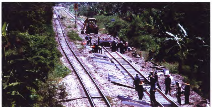
งานเปลี่ยนหมอนคอนกรีตช่วงชุมทางบางซื่อ-ชุมทางตลิ่งชัน ซึ่งเสร็จสมบูรณ์
