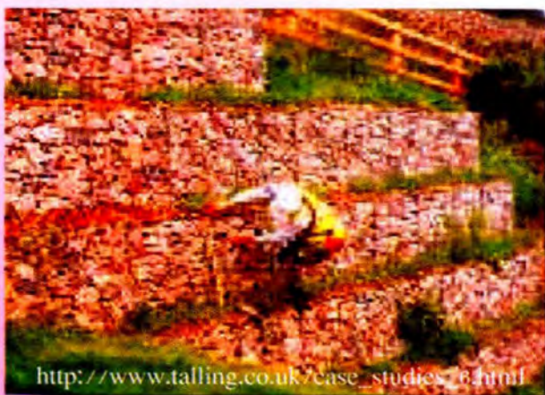
รูปที่ 27 แสดงการเลือกใช้กล่องตาข่ายบรรจุหินเพื่อป้องกันการถล่มของพื้นที่
