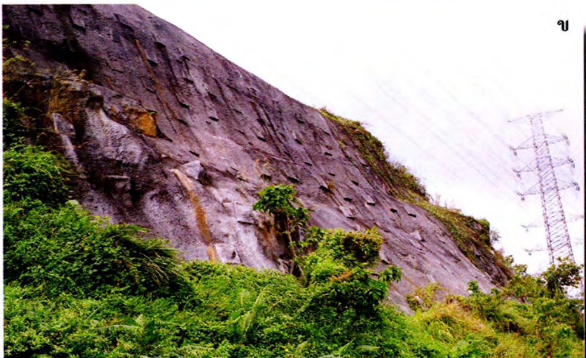
รูปที่ 22 ก : ขั้นตอนการฉีดพ่นปูนของการทำช็อคกริตเพื่อเพิ่มความแข็งแรงให้กับพื้นที่ ข : ช็อคกริตบริเวณทางหลวงหมายเลข 41 กิโลเมตร ที่ 248 อ.ทุ่งสง จ.นครศรีธรรมราช
