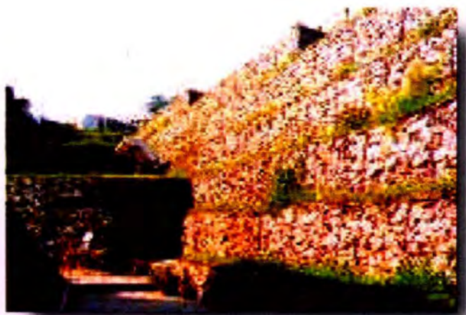
รูปที่ 27 แสดงการเลือกใช้กล่องตาข่ายบรรจุหินเพื่อป้องกันการถล่มของพื้นที่
