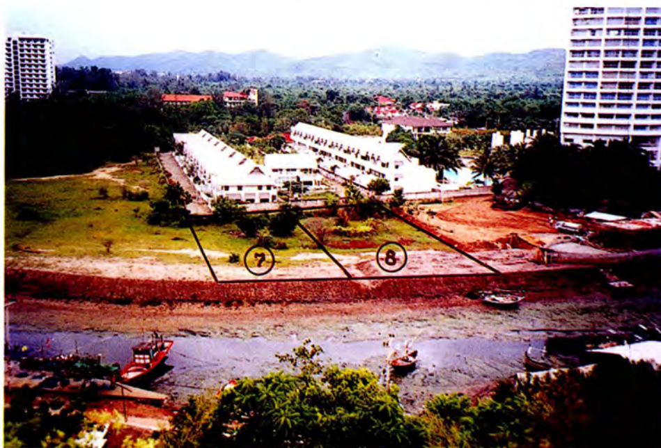
รูปที่ 36 การใช้ประโยชน์ที่ดินปีพ.ศ.2545 ของแปลงที่ 7 โฉนดที่ดินเลขที่ 4616 และแปลงที่ 8 โฉนดเลขที่ 3945 ตอนกลางของพื้นที่มีการถมดินให้สูงขึ้นและมีที่ลุ่มน้ำทะเลท่วมถึง และ ทศได้เป็นทุ่งหญ้าธรรมชาติ (ถ่ายจากด้านทิศเหนือเมื่อเดือนสิงหาคม 2545)
