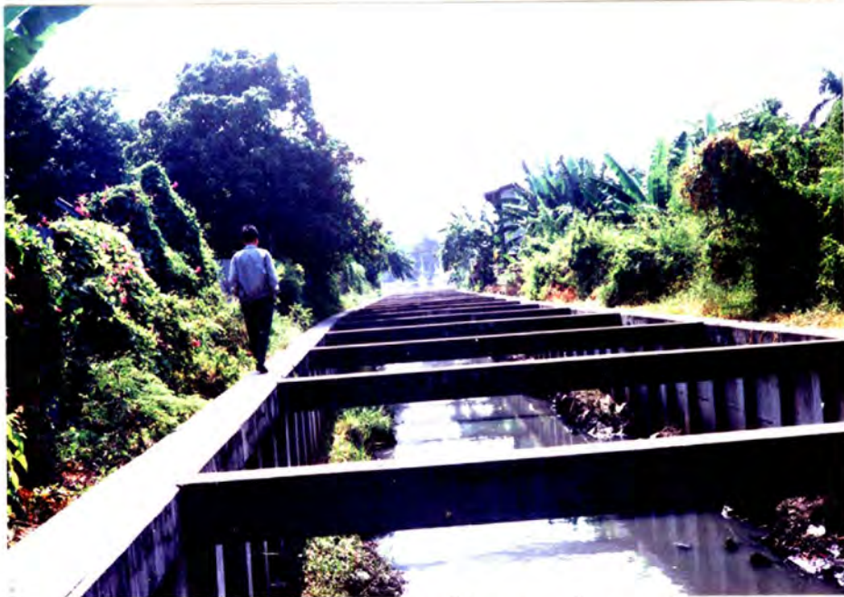
โครงการก่อสร้างระบบระบายน้ำและถนนเลียบบคลองช่องนนท์ ภาพปก : แนวคลองช่องนนท์ ช่วงแยกถนนสีลม
