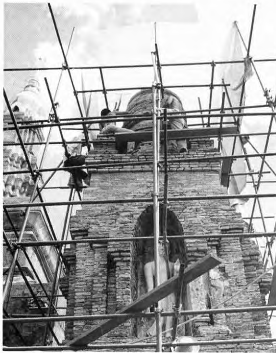
การเสริมความมั่นคงบริเวณเหนือเรือนธาตุ เจดีย์ทรงปราสาทยอดเจดีย์
