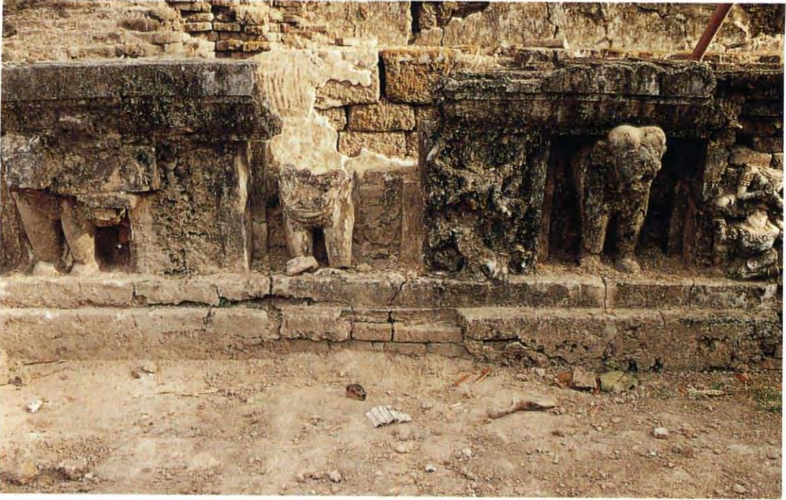
สภาพฐาน เจดีย์ห้ายอด ก่อนอนุรักษ์
