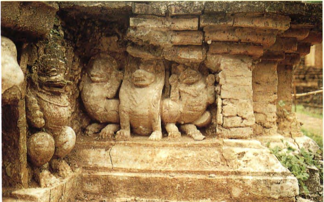
ปูนปั้นรูปสิงห์ประดับฐานเจดีย์หายอดด้านทิศใต้ แสดงสภาพปัจจุบัน (ก่อนการอนุรักษ์)
