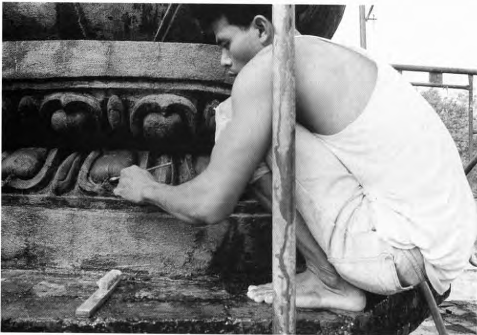
ทำความสะอาดฐานบัวด้วยน้ำสะอาด หากในกรณีที่มีคราบจับอยู่แข็งเกินไป เช่น คราบน้ำปูน จะใช้มีดผ่าตัด เลือกลักษณะและ ขนาดที่เหมาะสมกับพื้นที่นั้น ๆ ปฏิบัติด้วยความประณีตเพื่อไม่ให้ผิวเกิดความเสียหาย
