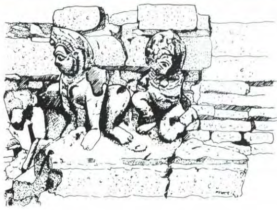
ปูนปั้นรูปยักษ์แคะระดับใต้ฐานเจดีย์ห้ายอดด้านทิศใต้ แสดงสภาพปัจจุบัน (ก่อนการอนุรักษ์)
