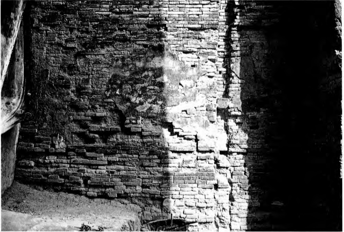
สภาพภายใน มณฑปพระอัฐฐารศปางเปิดโลก ก่อนอนุรักษ์และหลังอนุรักษ์
