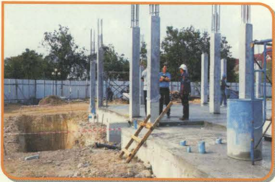
▲ ความก้าวหน้าการก่อสร้างอาคารศูนย์ควบคุมมลพิษ จังหวัดระยอง ณ วันที่ 8 มกราคม 2558
