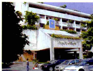
อาคารที่ 3 (ตึกใต้ - 6 ชั้น)
