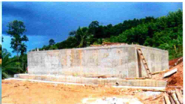
ก่อสร้างถึงฝักน้ำ ขนาดความจุ ๒๗๕ ลูกบาศก์เมตร จำนวน ๑ แห่ง
