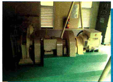
เครื่องกังหันน้ำพร้อมเครื่องกำเนิดไฟฟ้า และอุปกรณ์ประกอบ 1 ชุด
