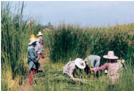
ภาพที่ 8 การตัดพืชที่ครบกำหนดเวลาเพื่อบำรุงรักษาและเพิ่มประสิทธิภาพของระบบพื้นที่ชุ่มน้ำเทียม
