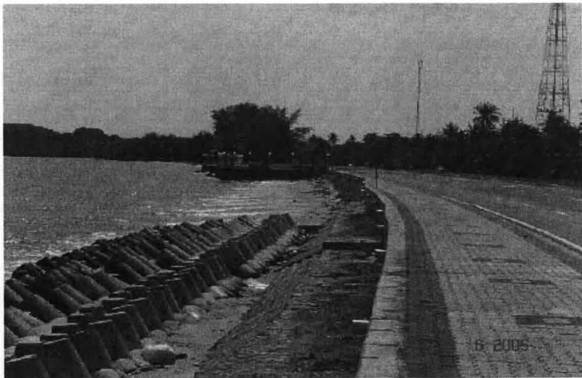
รูปที่ ๔ กำแพงกันคลื่นซึ่งจัดเรียงด้วยแท่งคอนกรีต
