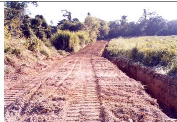
แสดงสภาพของถนนป่าไม้ลำลองที่ทำการยกคันทางแล้วเสร็จ โดยการขุดร่องน้ำ
