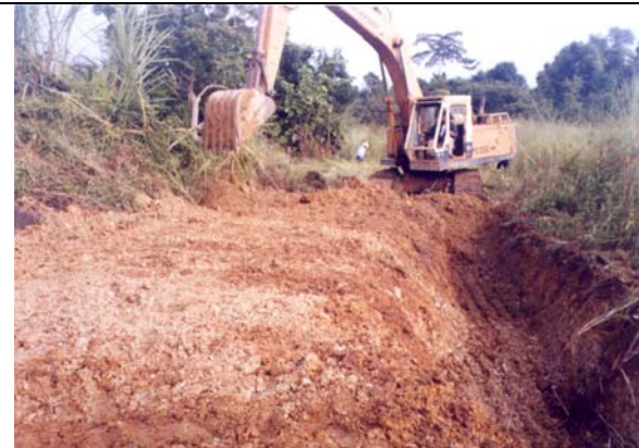
แสดงการใช้เครื่องจักรกลทำการขุดร่องน้ำ และทำการยกคันทางถนนป่าไม้ลำลอง
