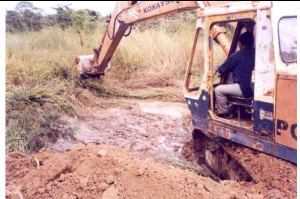
แสดงการทำงานของเครื่องจักรกลในการเปิดแนวและก่อสร้างถนนป่าไม้ลำลอง
