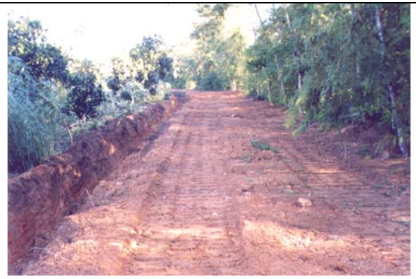
แสดงสภาพของถนนป่าไม้ลำลองที่ทำการยกคันทางแล้วเสร็จ โดยการขุดร่องน้ำ
