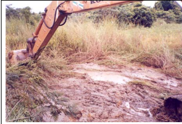
แสดงการทำงานของเครื่องจักรกลในการเปิดแนวและก่อสร้างถนนป่าไม้ลำลอง
