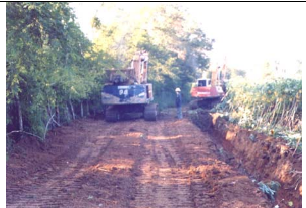
แสดงการใช้เครื่องจักรกลทำการขุดร่องน้ำ และทำการยกคันทางถนนป่าไม้ลำลอง
